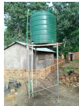
Waterreservoir bij het nieuw sanitair blok van de secundaire school
